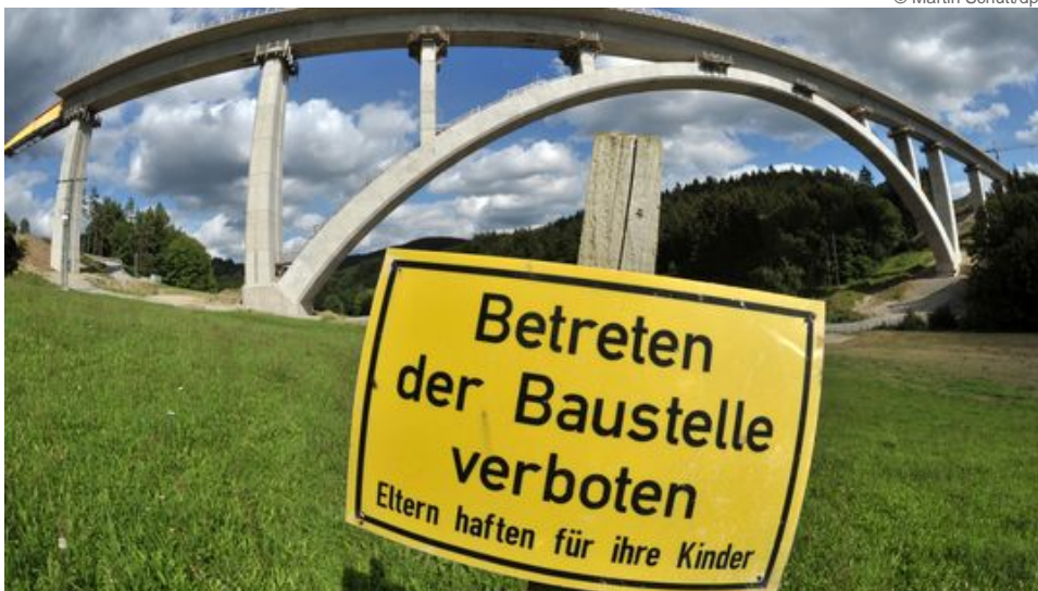
ICE-Baustelle der Deutschen Bahn
