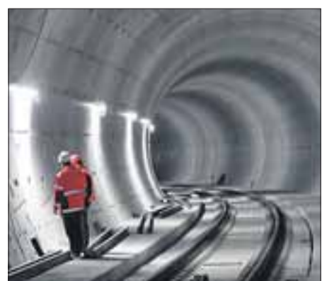
Leipzigs City-Tunnel wird fast eine Milliarde Euro kosten.
