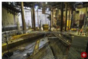
Die Baustelle an der U-Bahn-Haltestelle Heumarkt
