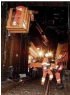
Arbeiten im ersten S-Bahn-Tunnel im Jahr 2004
